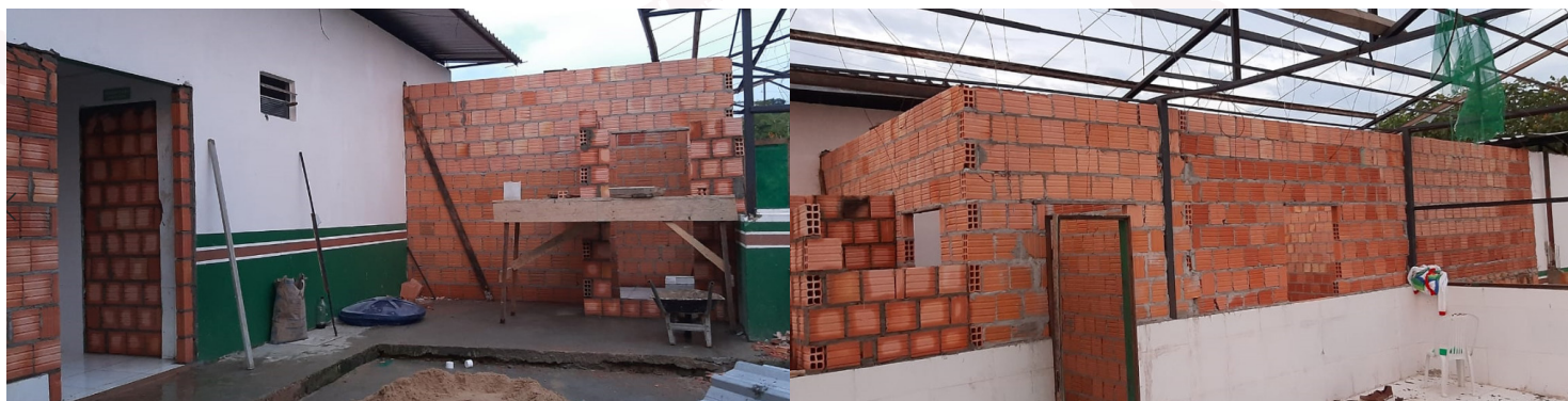
Obra de adequação realizada no entreposto de processamento do pirarucu salgado e seco no município de Fonte Boa (AM).
