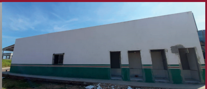
Adequações da obra da salgadeira cabocla
