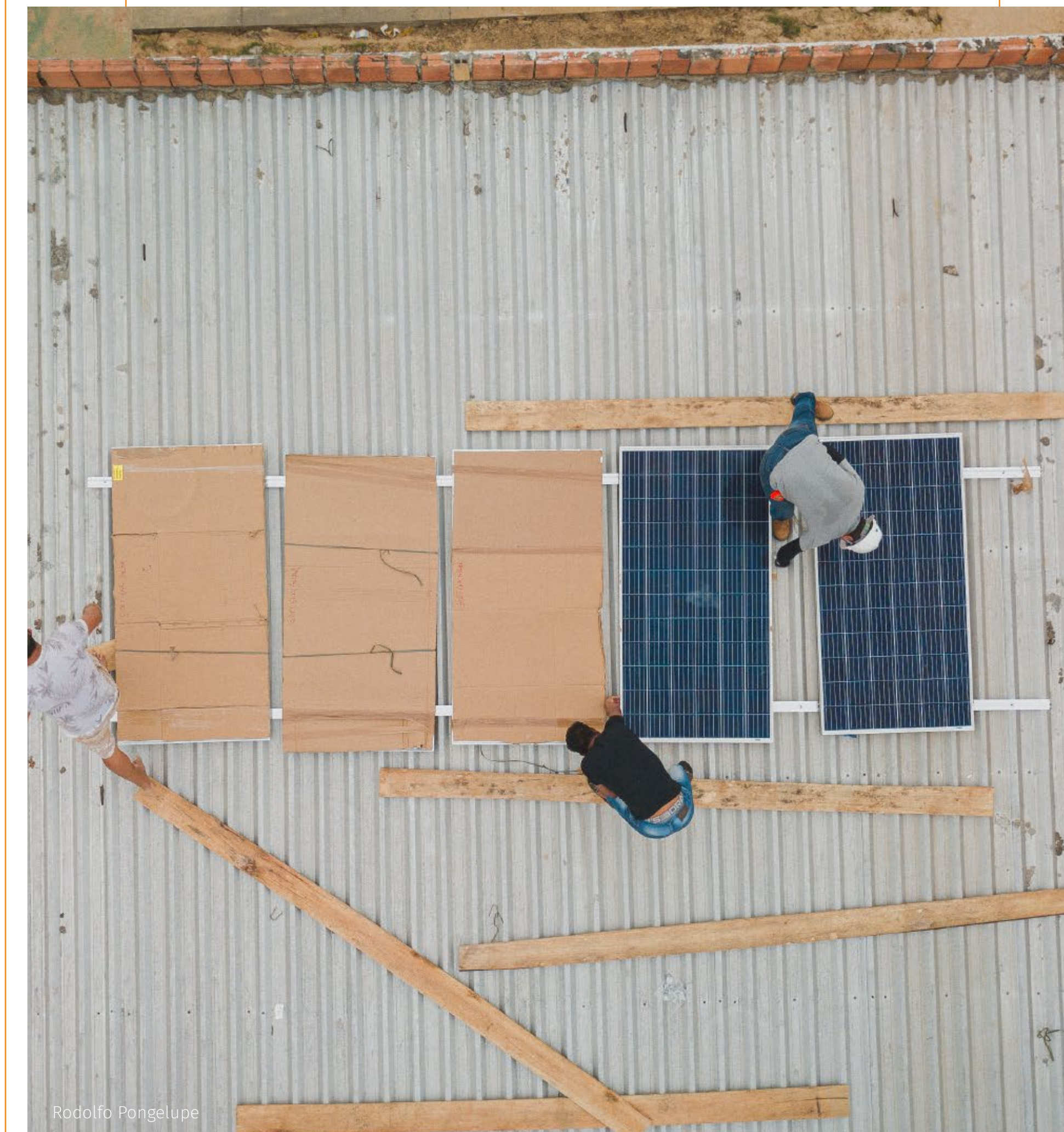
Instalação de sistema de energia solar e de internet na salgadeira para auxiliar no beneficiamento do pirarucu na comunidade de Fonte Boa (RDS Mamirauá).
