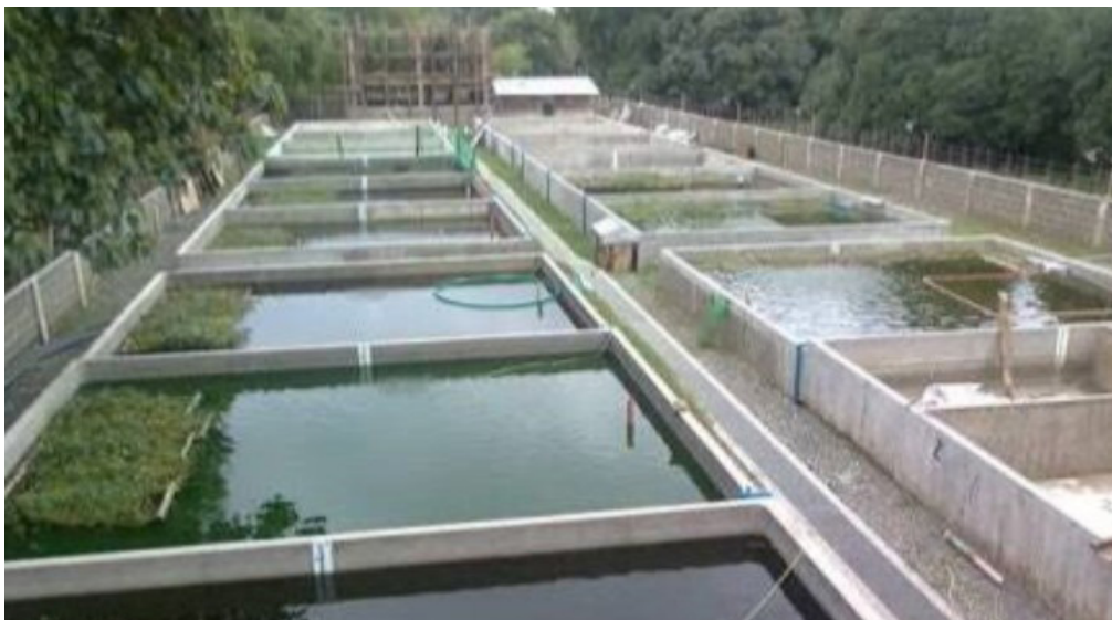
Tanques de alvenaria
