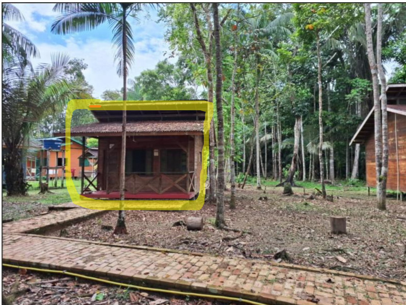
Figuras 2 – Local de instalação do polo de atendimento à saúde na comunidade Bauana, Carauari/AM (ao lado da edificação marcada)
