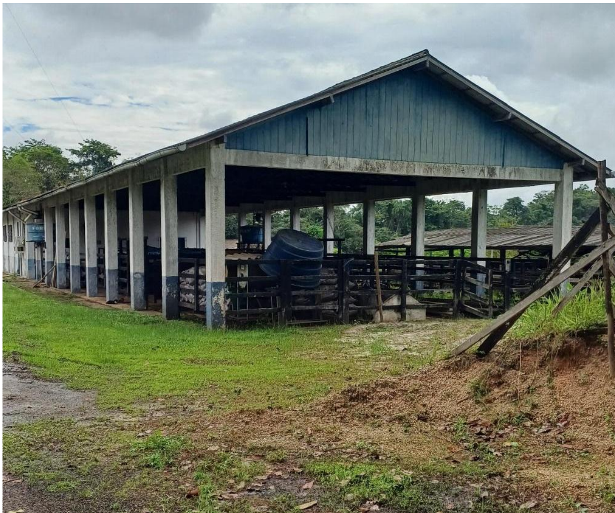
Imagem 06: Fachada principal do atual Galpão de Alimentação Animal
