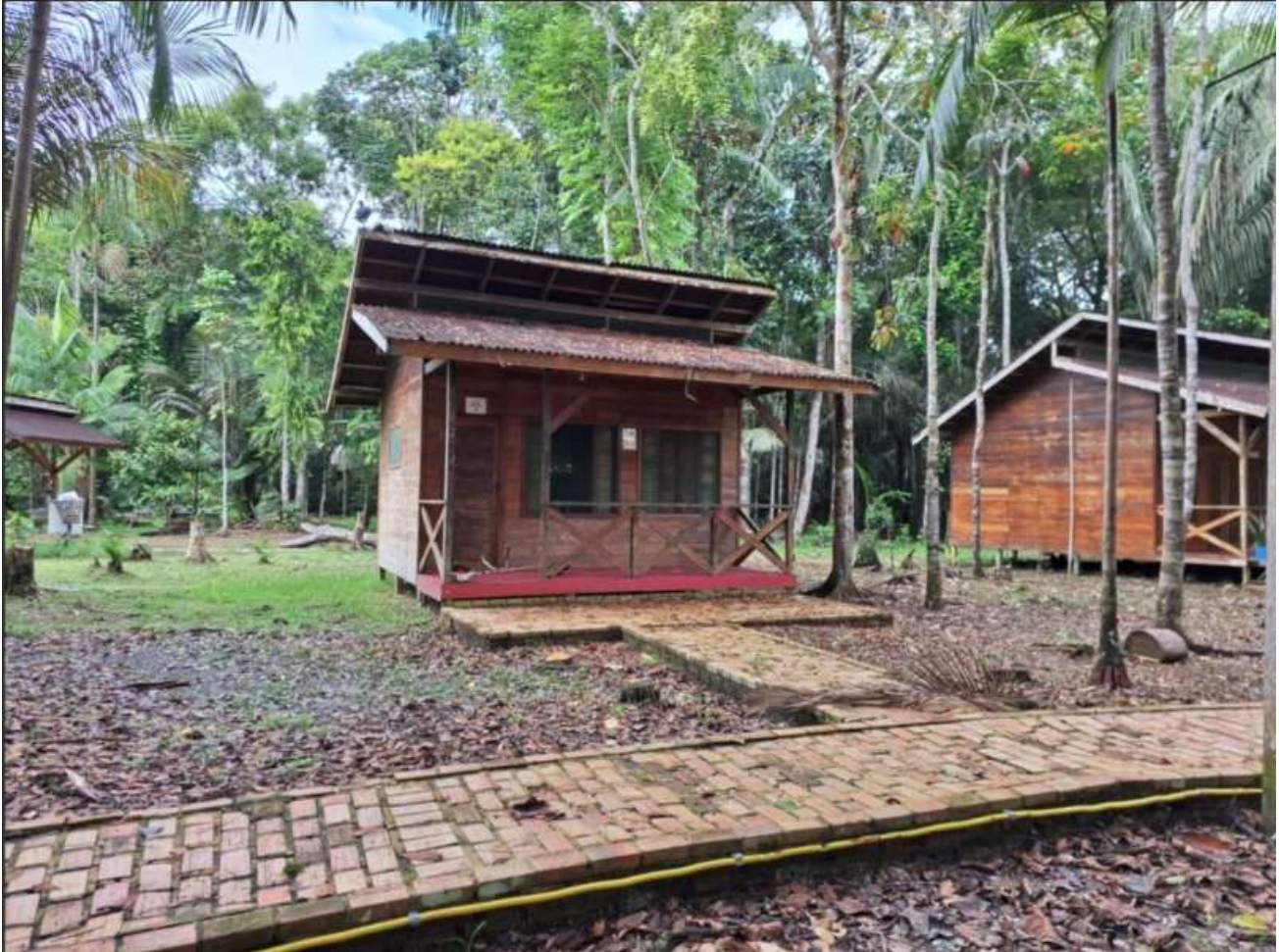
Figura 3 – Local de instalação do polo de atendimento à saúde na comunidade Bauana, Carauari/AM
