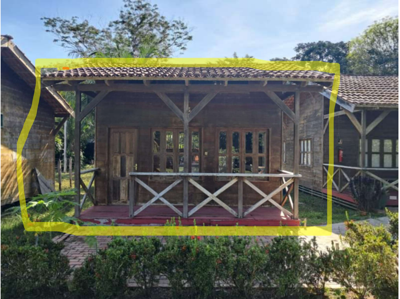
Figura 2 – Local de instalação do polo de atendimento à saúde na comunidade Boa Frente, Novo Aripuanã/AM (área marcada)
